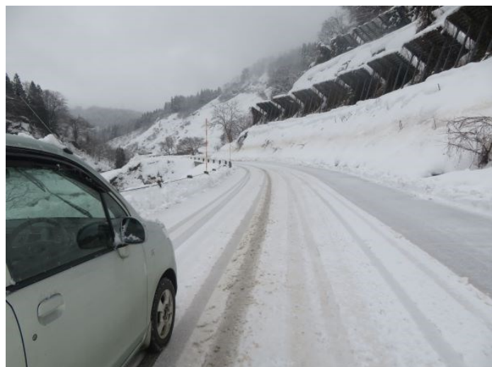
県道上越安塚柏崎線大島区板山地区で発生した地滑りの災害復旧工事がこのほど完了し、12月24日の午前10時から通行できるようになりました。写真は同日の11時過ぎに撮影したものです。
