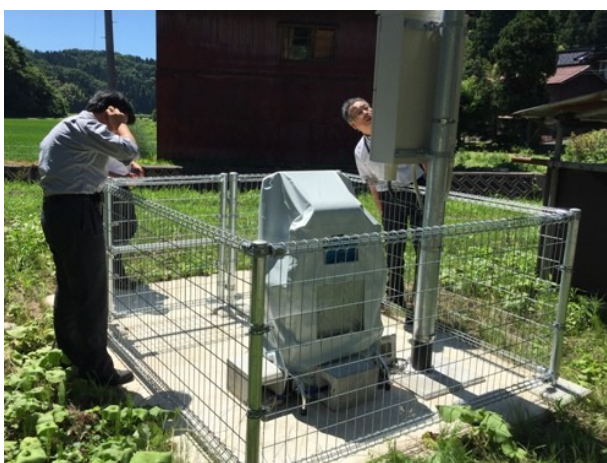
カバーがかけられたままのモニタリングポスト。7月、柿崎区雁海にて調査する日本共産党議員団。
