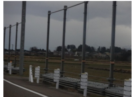
県道新井柿崎線、江島一馬正面間の防雪柵（「吹き払い柵」とも呼ぶ）の修繕などの工事がようやく始まりしました。ここについては昨冬、一部で柵が飛ばされるという事故が起き、その原因を究明した後、修繕工事を行うことになっていました。原因については説明があり次第、お知らせします。
