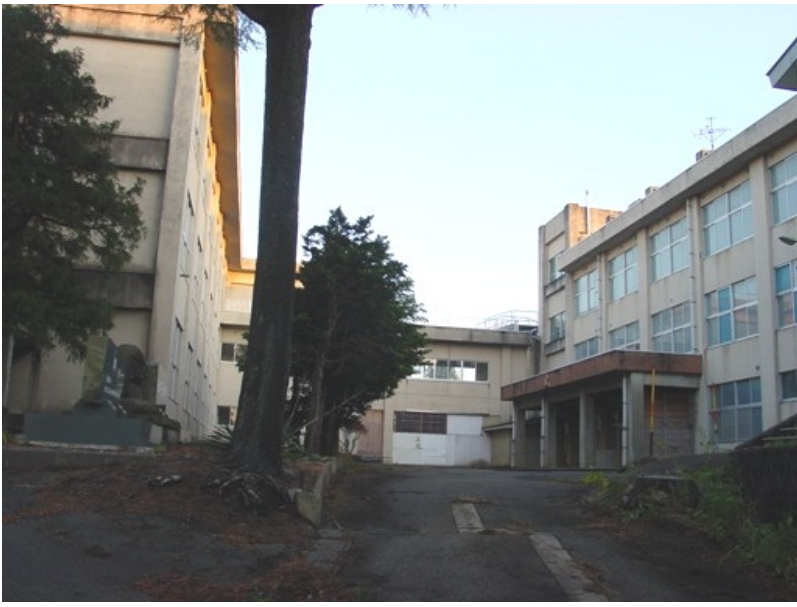
高等特別支援学校になった場合、左の建物は普通教室棟に、右側の建物が管理棟になります。醸造科閉科などの記念碑はそのまま。手前の大きな木は生かされますが、奥の小さな木は伐採され、駐車場用地として活用されるとのことです。
