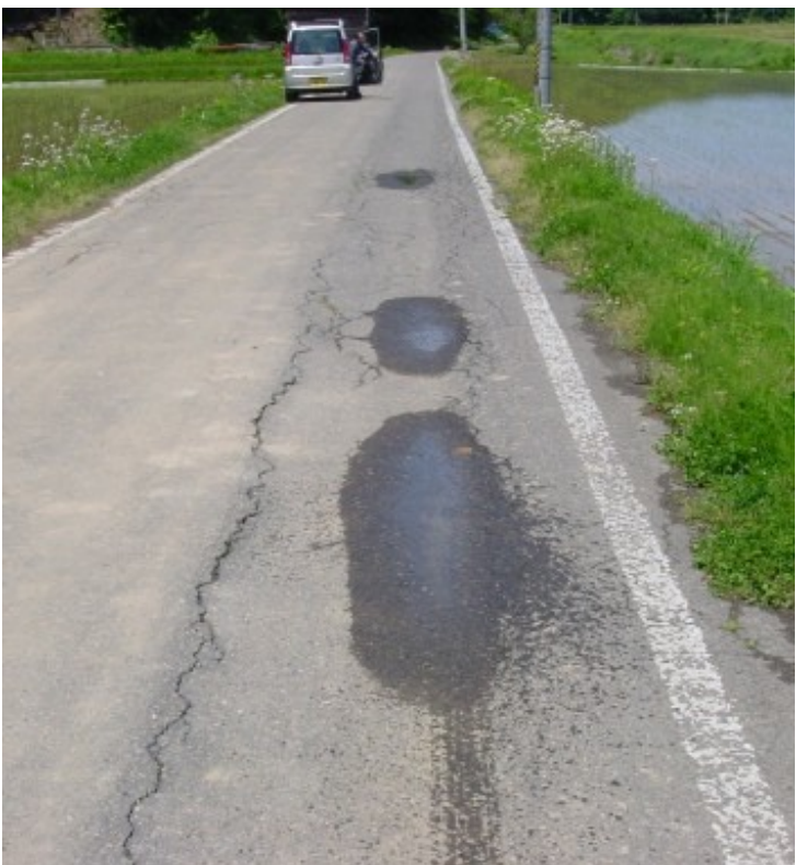
【写真上】こわれた側溝のふた（源地区）。これは直ちに総合事務所に連絡。同事務所からは即日対応したと報告がありました。【写真右】陥没したままの路面（下中条地内）【写真下】陥没し、ひび割れもしている路面（福平地内）写真はいずれも14日午前撮影。
