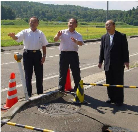
山方地内で農業集落排水管路の被害状況を視察する竹内議長（右側）など。左は佐々木所長と私。
