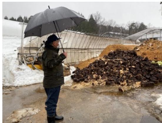
壊れた部分のパイプを切ったハウス。堆肥置き場として利用していた。
