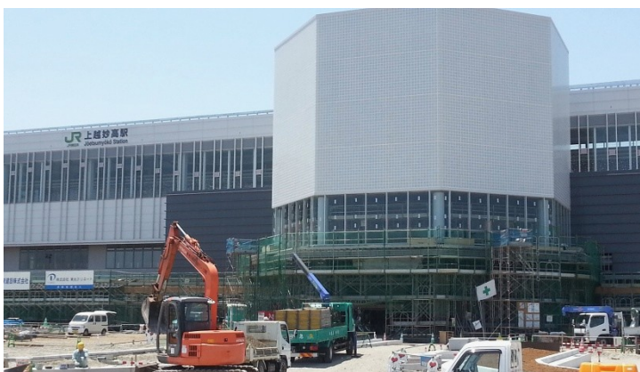
急ピッチ工事が進む新幹線上越妙高駅
